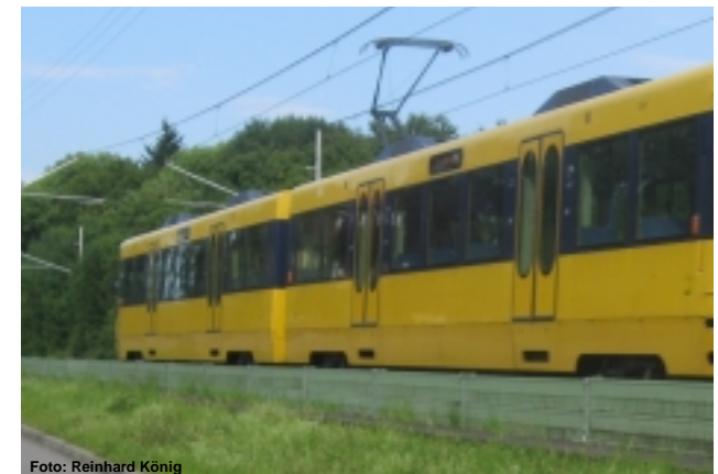
Lärmabsorptionswand an einer Stadtbahntrasse
