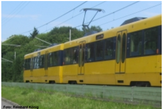
Lärmabsorptionswand an einer Stadtbahntrasse
